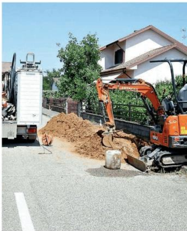
I lavori per riparare il guasto in via Girardengo, a Cielo Alto
