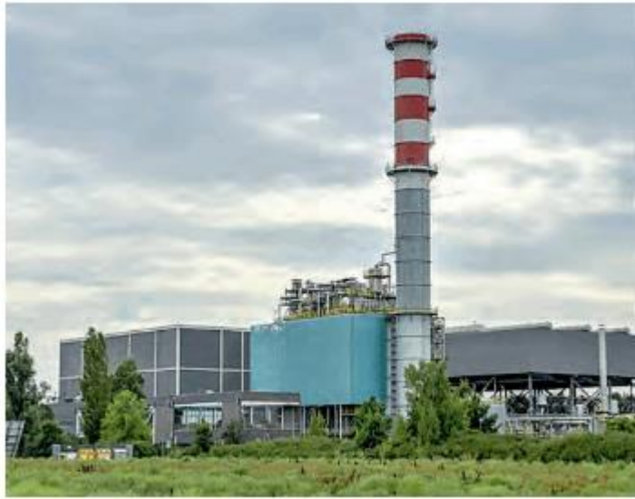
La centrale di Torremenapace alimenta il teleriscaldamento
