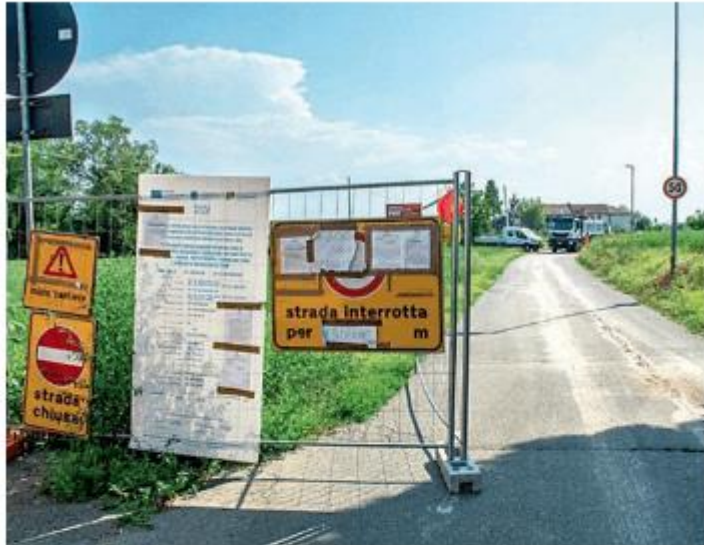
Una veduta di via Pasquà, la strada verrà chiusa per lavori
