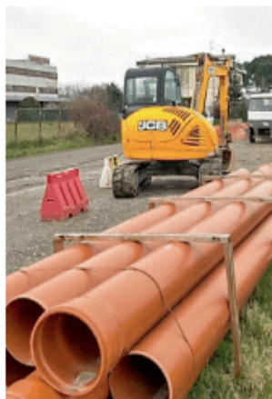
Un cantiere di Pavia Acque
