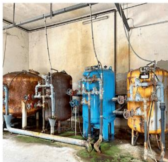
Le vecchie strutture dell'acquedotto di Cornale e Bastida
