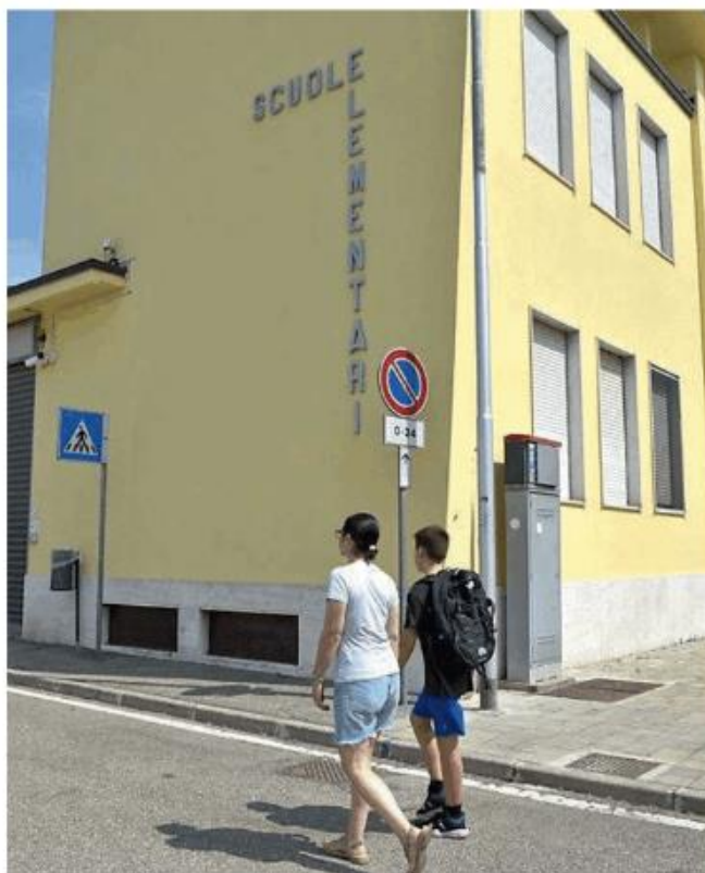
La perizia certifica che è sicuro l'edificio che ospita elementari e medie
