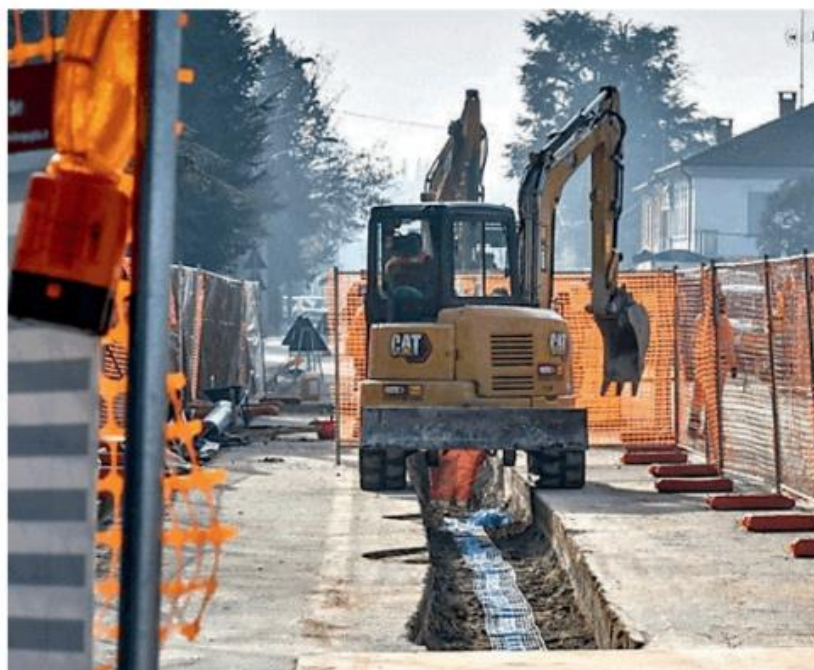
Lavori alla rete idrica di Voghera (archivio)
