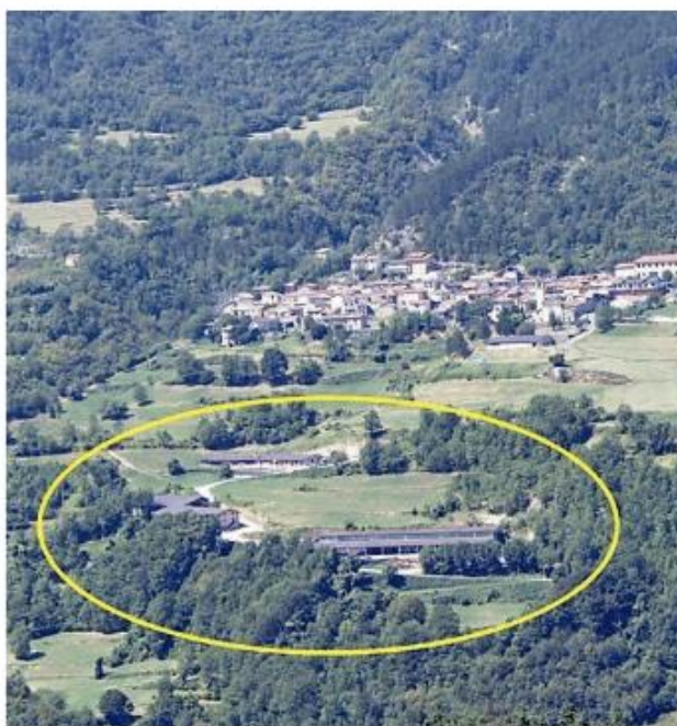
Nel cerchio la zona di intervento, sopra la frazione Cegni
