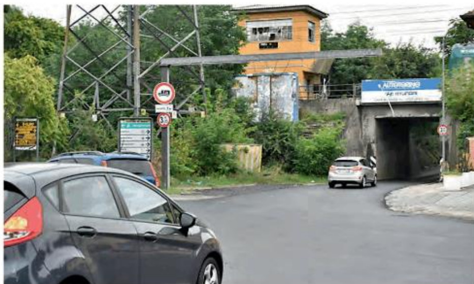
Il sottopasso della linea ferroviaria Milano-Genova riaperto al traffico
