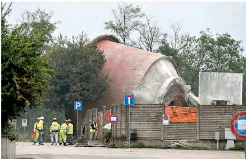
In alto il momento dell'esplosione delle cariche e, in basso, la vecchia torre abbattuta
