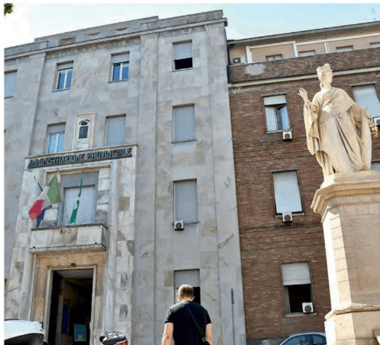
La sede dell'amministrazione provinciale in piazza Italia
