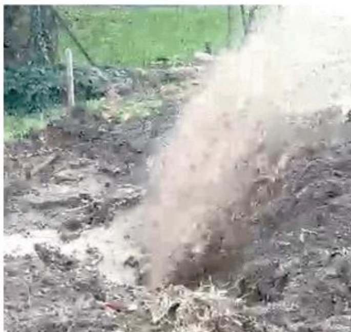
Il getto d'acqua provocato dalla rottura del tubo dell'acquedotto
