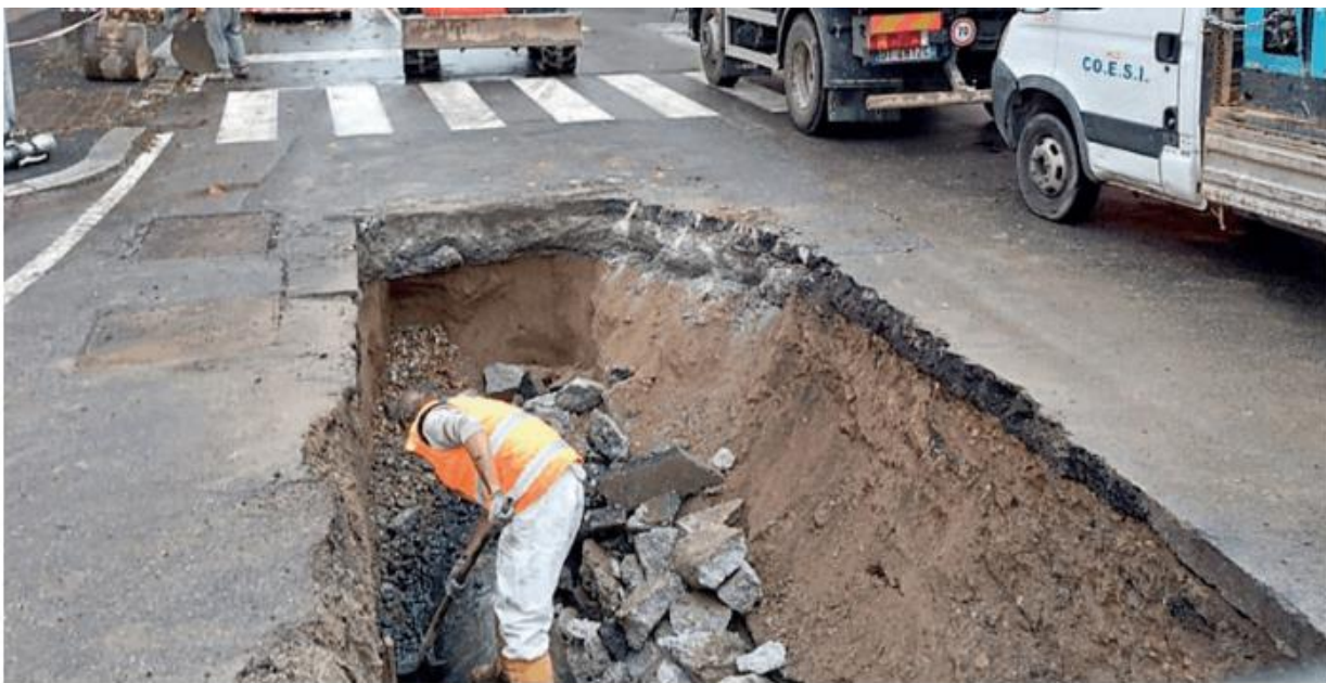
Lo scavo aperto in via San Paolo per raggiungere il tratto di fognatura da sostituire
