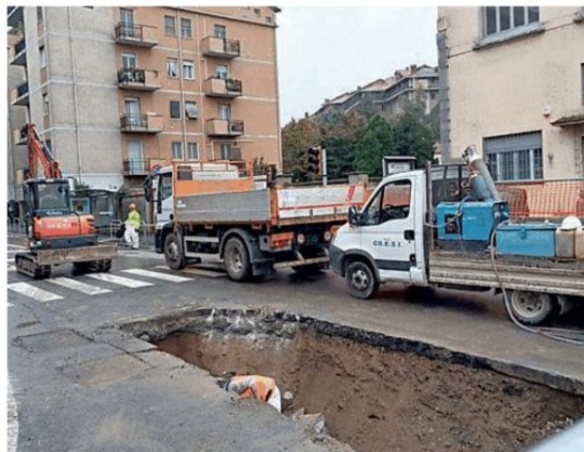
Il grosso scavo necessario a raggiungere i tubi della fognatura
