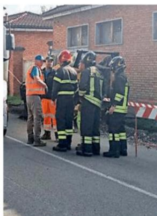
L'intervento per la fuga di gas
