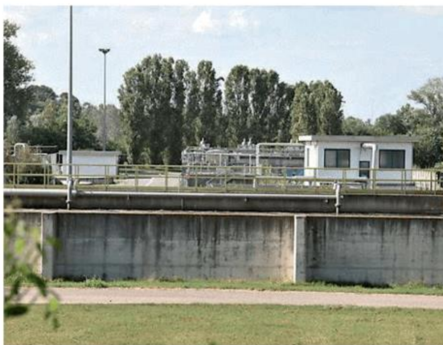
L'impianto di depurazione comunale, in via Aguzzafame
