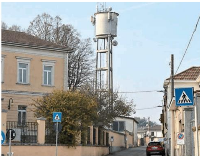
La torre dell'acquedotto in via Cordara destinata all'abbattimento
