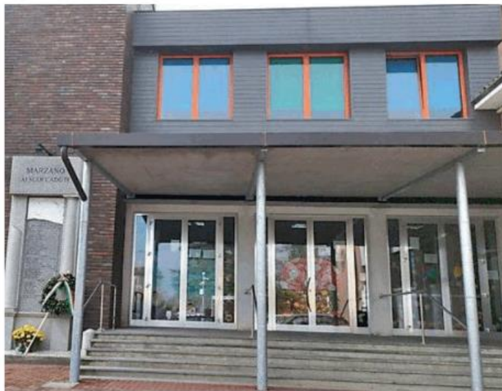
L'ingresso delle scuole a Marzano: oggi gli studenti restano a casa
