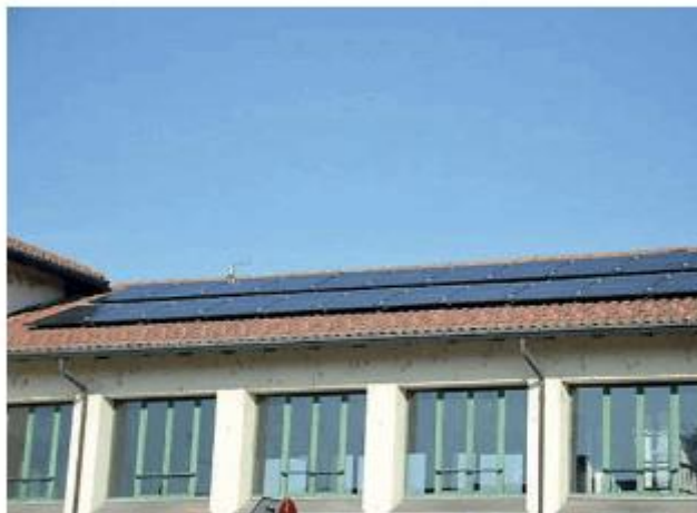
I pannelli fotovoltaici installati sul tetto del Comune
