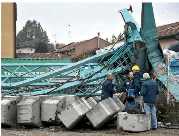
L'incidente della gru che schiacciò due operai a Trivulzio del novembre 2022 è finito nell'inchiesta
